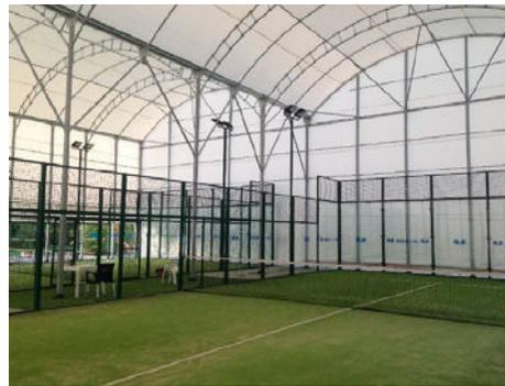
Les structures sont en acier galvanisé à chaud Z-450 et Z-275 avec jambes de force longitudinales et transversales.
